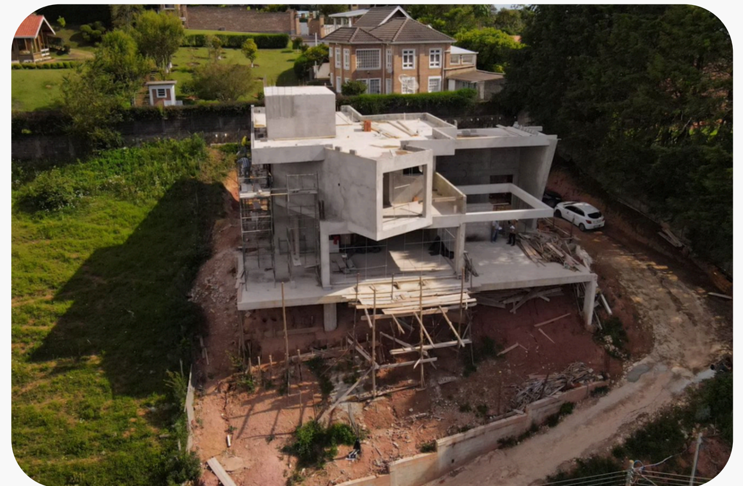
Campos do Jordão, SP Obra em andamento
