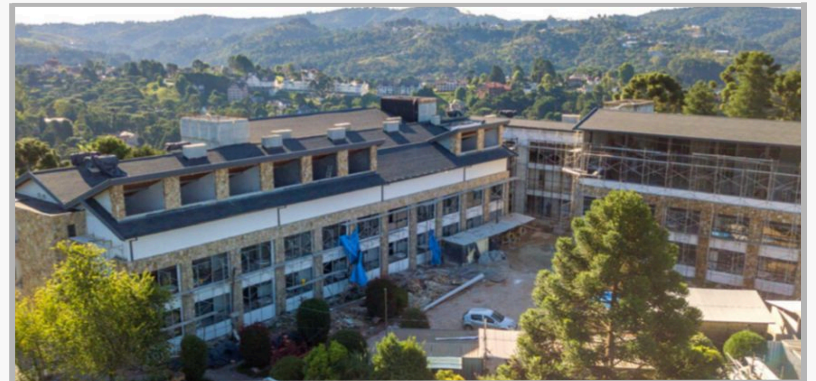
OBRA EM ANDAMENTO
